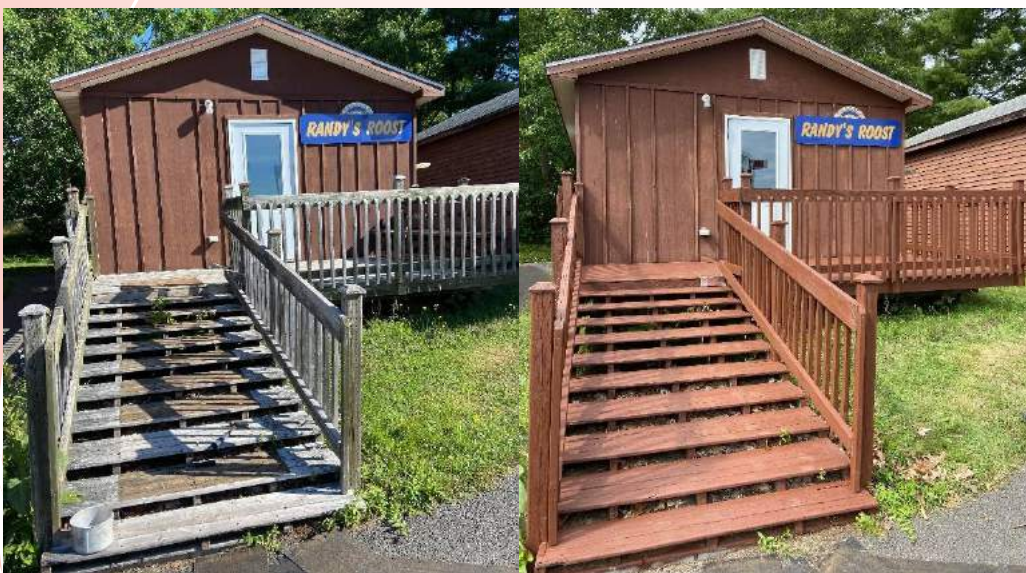
Avant et après d'une de nos tâches d'entretien pendant l'été: reteindre les terrasses des cabines!
